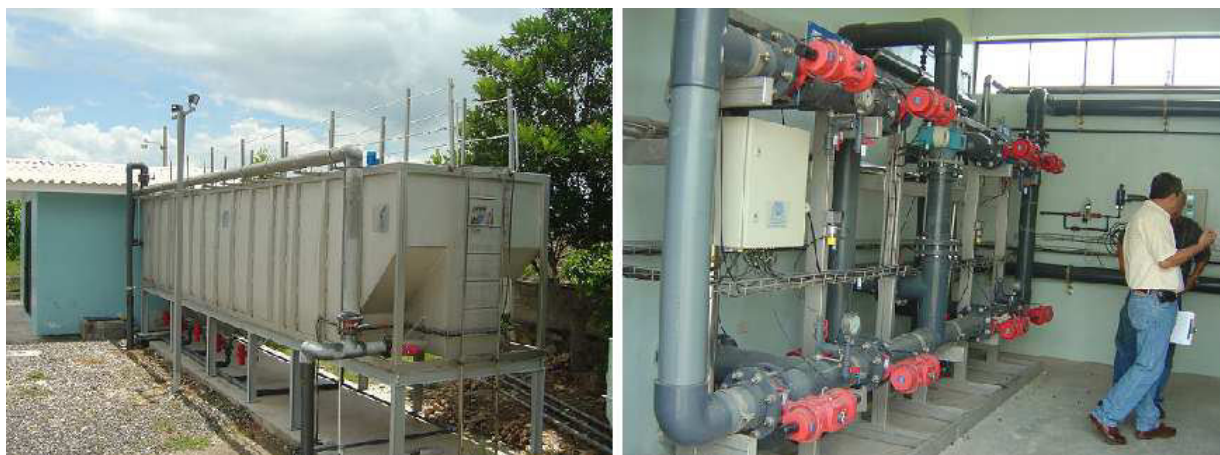
FOTOGRAFÍA 4: MANTENIMIENTO DE PLANTAS POTABILIZADORAS MODULARES INCLUYENDO LA COMPLEJA FONTANERÍA
