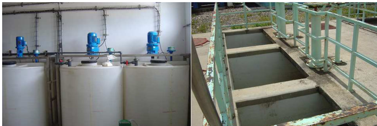
FOTOGRAFÍA 6: ACCIONES ESPECIALIZADAS DE MANTENIMIENTO EN PLANTAS POTABILIZADORAS
