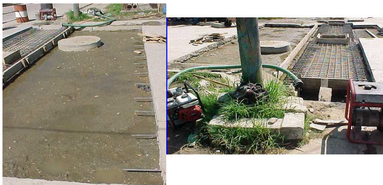
FOTOGRAFÍA 7: EJEMPLOS DE REPARACIÓN DE PAVIMENTOS
