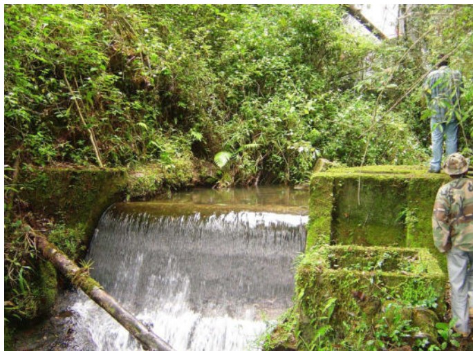
FOTOGRAFÍA 1: MANTENIMIENTO DE PRESAS
