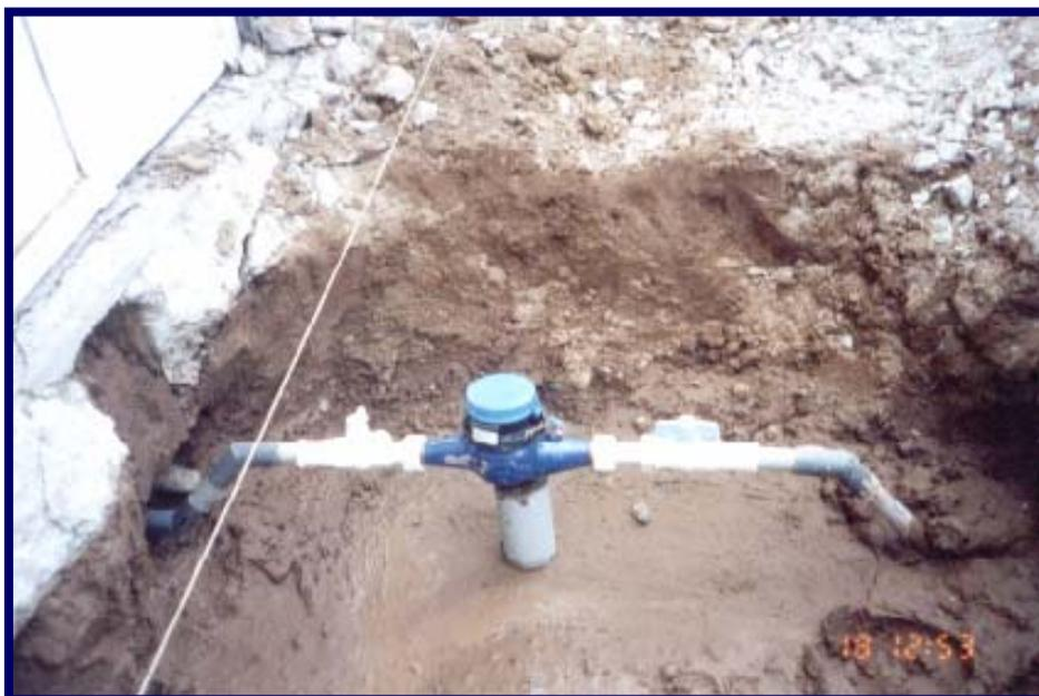
**Figura 8. Medidor instalado en la acera**
