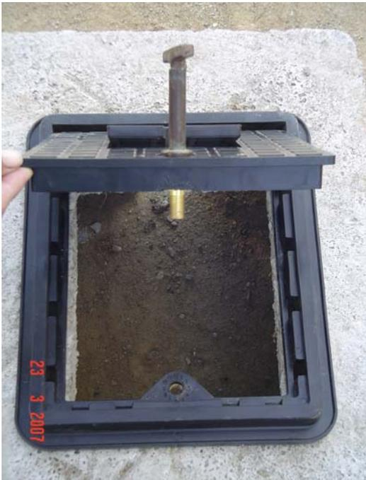
**Figura 11. Tapa de medidor con visor para lectura de medidor y apertura completa para mantenimiento**
