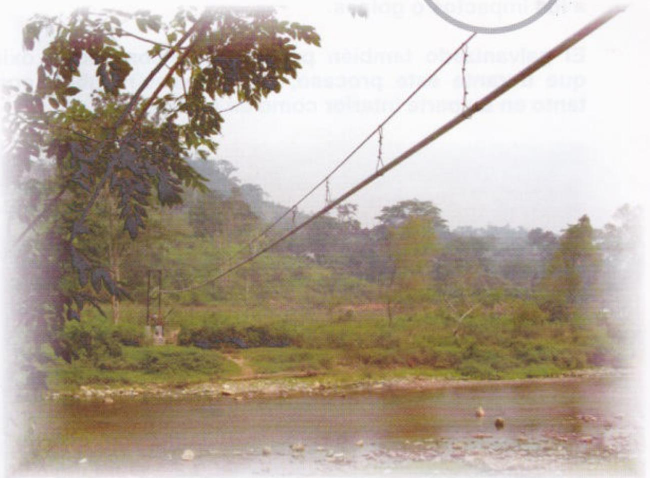
La utilización del tubo HG se recomienda para instalarlos en *cruces aéreos* o sobre la superficie de los terrenos rocosos, ya que por su dureza, los costos de excavación en este tipo de terrenos, son muy altos.
