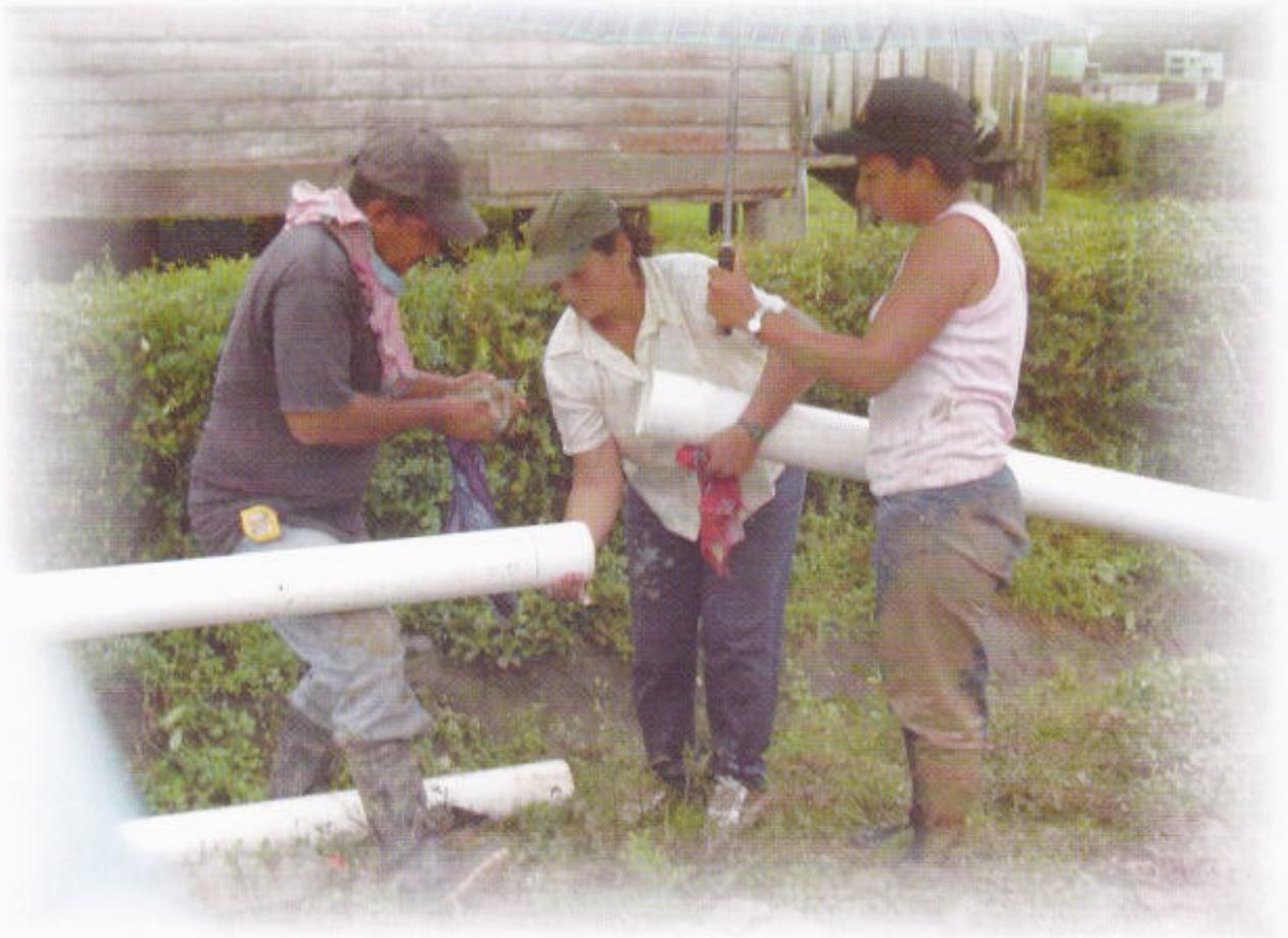
Las tuberías son la parte más importante de un sistema de agua potable. La buena o acertada selección de la tubería permitirá lograr un mejor proyecto. En el mercado existen varias clases de tubos, de los cuales, los más usados en los sistemas, son los que están hechos de plástico, o PVC y los de hierro galvanizado, o HG.
